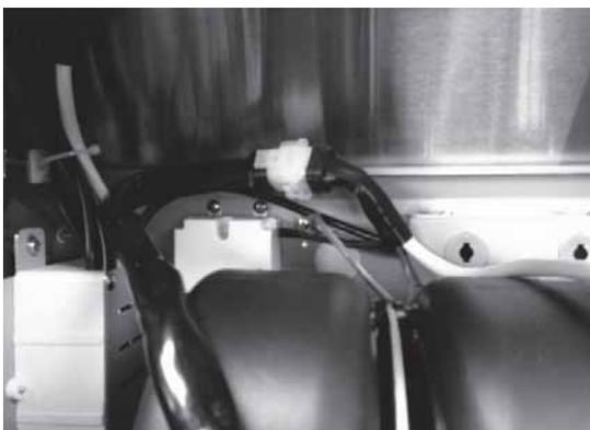
5. Branchez le connecteur Molex à neuf broches du moteur interne au connecteur Molex à neuf broches du câble du boîtier du condensateur. Fixez le câble à l'intérieur de la hotte avec une attache mono-usage et un porte-attache mono-usage.
