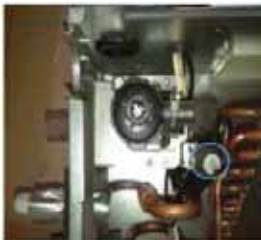
Pompe à condensat intégrée avec interrupteur à flotteur
